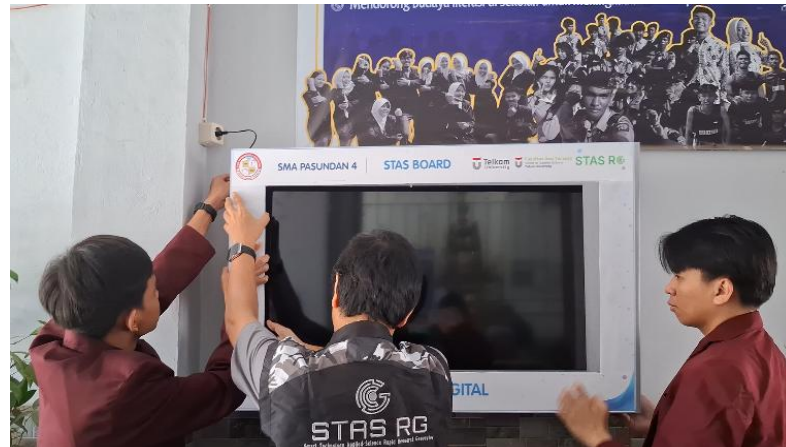
Gambar 2. Pemasangan TV Mading Digital
